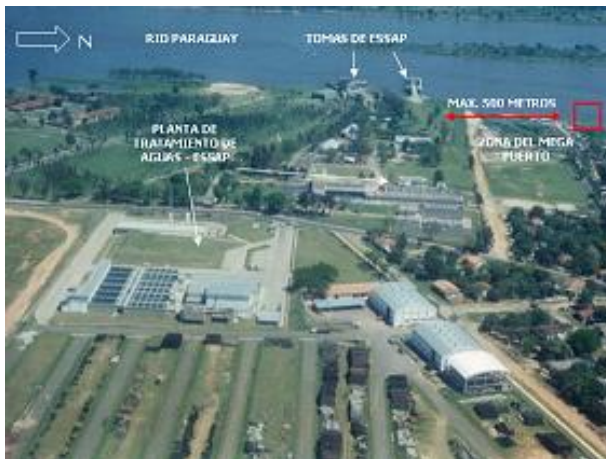
Foto 4. La ubicación del nuevo puerto de Cargill en Asunción está ubicado a menos de 500 metros de la toma de agua potable.
